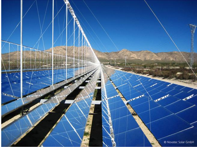
Abbildung 4: Bild eines Fresnel-Kraftwerks
